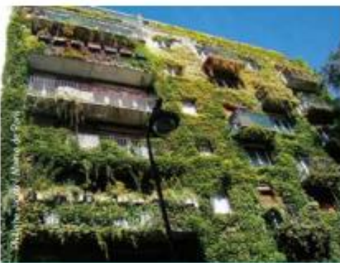
Toitures et façades végétalisées : des continuités écologiques dans la ville pour la biodiversité et l'adaptation au changement climatique.
